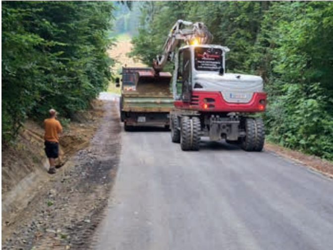
Arbeiten am Neurath-Statzenbachweg
