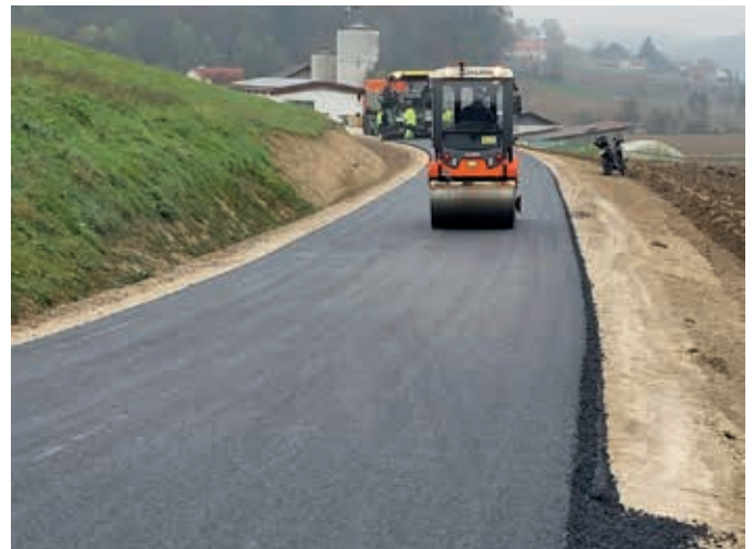
Asphaltierungsarbeiten am Neurath-Statzenbachweg
