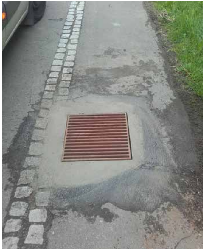
Sanierung Entwässerungsrinne Lödersdorf
