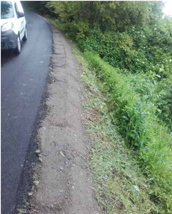
Asphaltierung und Bankettherstellung in Krennach
