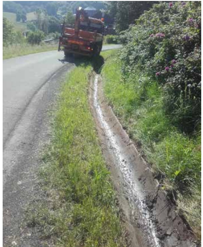
Grabenputzen in Schützing
