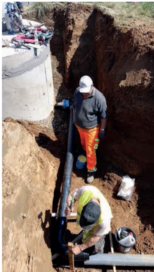
Unten: Errichtung eines Wasserzählerschacht in Schützing
