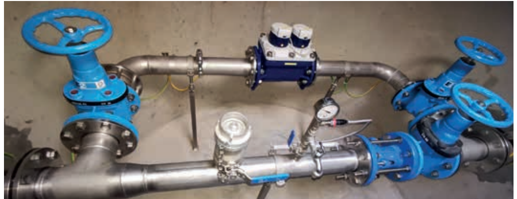
Neuer Messzählerschacht im Bereich Kapelle Kreuzung Schützing
