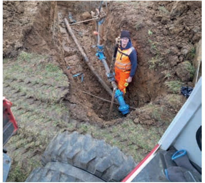
Bankettwiederherstellung nach Glasfasergrabungen sowie Wasserleitungsbau
