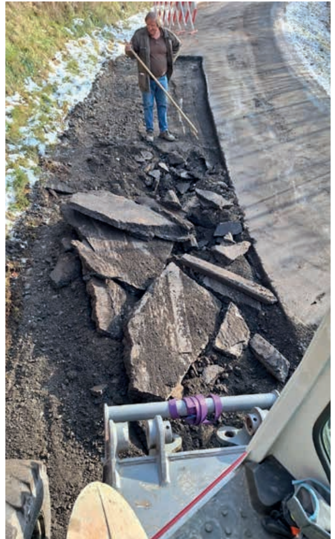
Wegesanieung nach Hangrutschung
