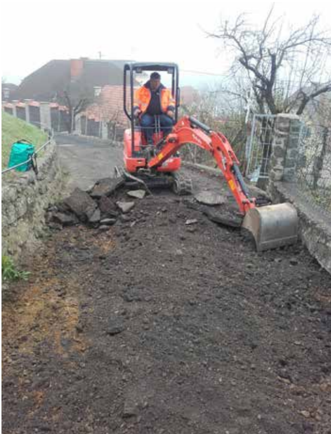
Generalsanierung „Enggassl“ Riegersburg
