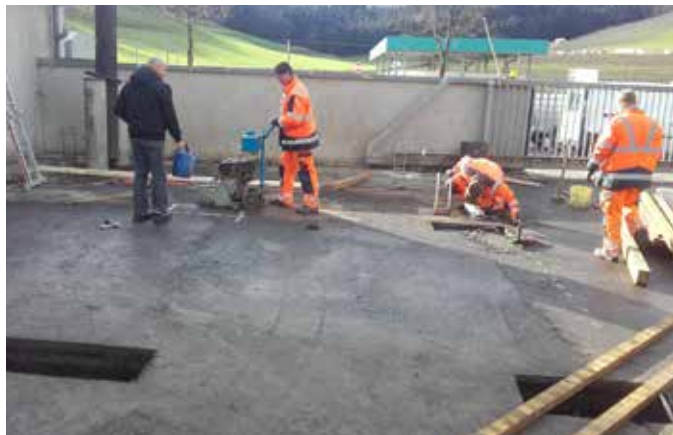
Umbauarbeiten im ASZ Riegersburg
