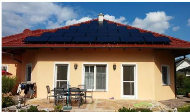
Beispiel einer 5 kWp Photovoltaik-Anlage eines Einfamilienhauses
