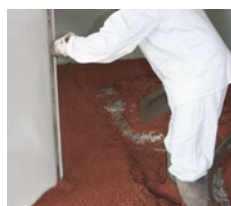
Lehren (Faschen) schütten, verdichten und auf Niveau abziehen.
