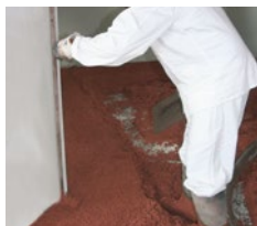
Lehren (Faschen) schütten, verdichten und auf Niveau abziehen.
