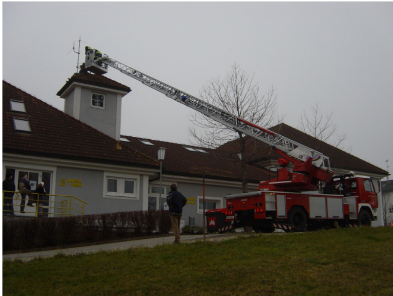
Antennenmontage für neues Warn- und Alarmsystem
