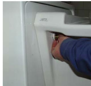
d) Zulaufschlauch am Spülkasten anschließen und mit Schlauchband sichern
