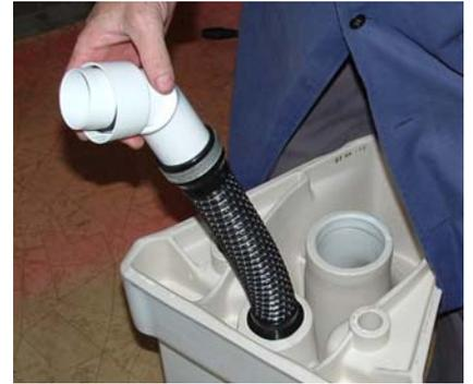
b) Abwasserflexschlauch an der Schüssel anschließen und mit Sicherungsband fixieren
