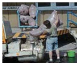
1 Sack (200 Liter) mit 10 - 12 Liter Wasser (je nach Produkt) in Estrichpumpe zu einer homogenen Dämmung mischen (ca. 2 Min. Mischzeit).
