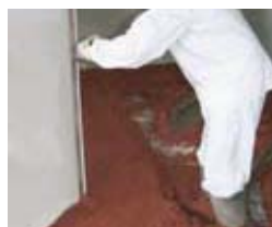
Lehren (Faschen) schütten, verdichten und auf Niveau abziehen.
