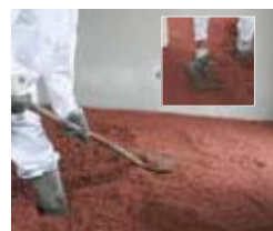
Die Anschlusskanten an der Mauer nacharbeiten und aufgetragene Fläche verdichten.
