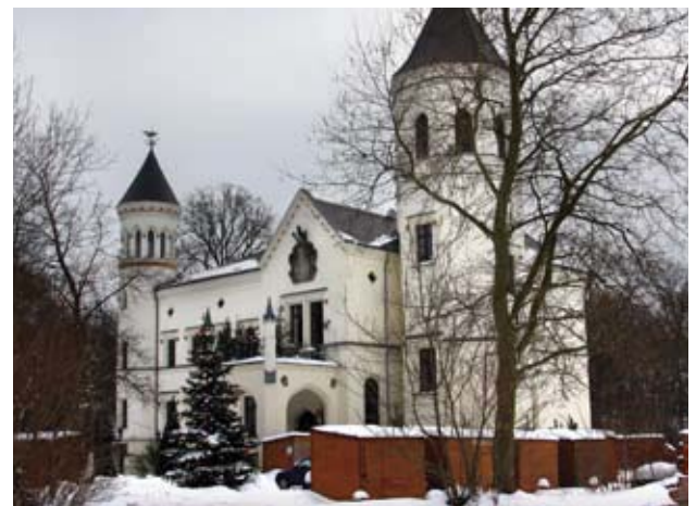
Schloß Bredenfelde, Mecklenburg-Vorpommern Bei der Sanierung der Fußböden wurde aufgrund des Zeitdrucks Gussasphalt eingesetzt. Die historischen Holzdecken wurden dazu mit thermotec® BEPS-WD 130R ausgeglichen, um einen gleichmäßig dicken Estrich zu gewährleisten.
