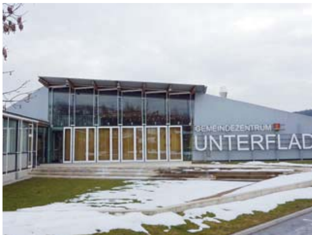
Gemeindeamt, Unterfladnitz thermotec® BEPS-WD 130R, Fesco-Platte, 400 - 500 m 2 Gussasphalt
