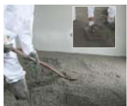
Die Anschlusskanten an der Mauer nacharbeiten und aufgetragene Fläche verdichten.
