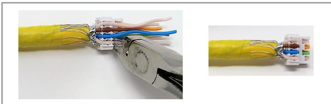
Adern mit einem watenfreien Seitenschneider bündig kürzen.
