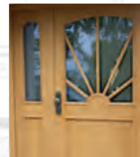
Haustüre Eiche massiv, lackiert, Isolierverglasung mit Sandstrahlung
